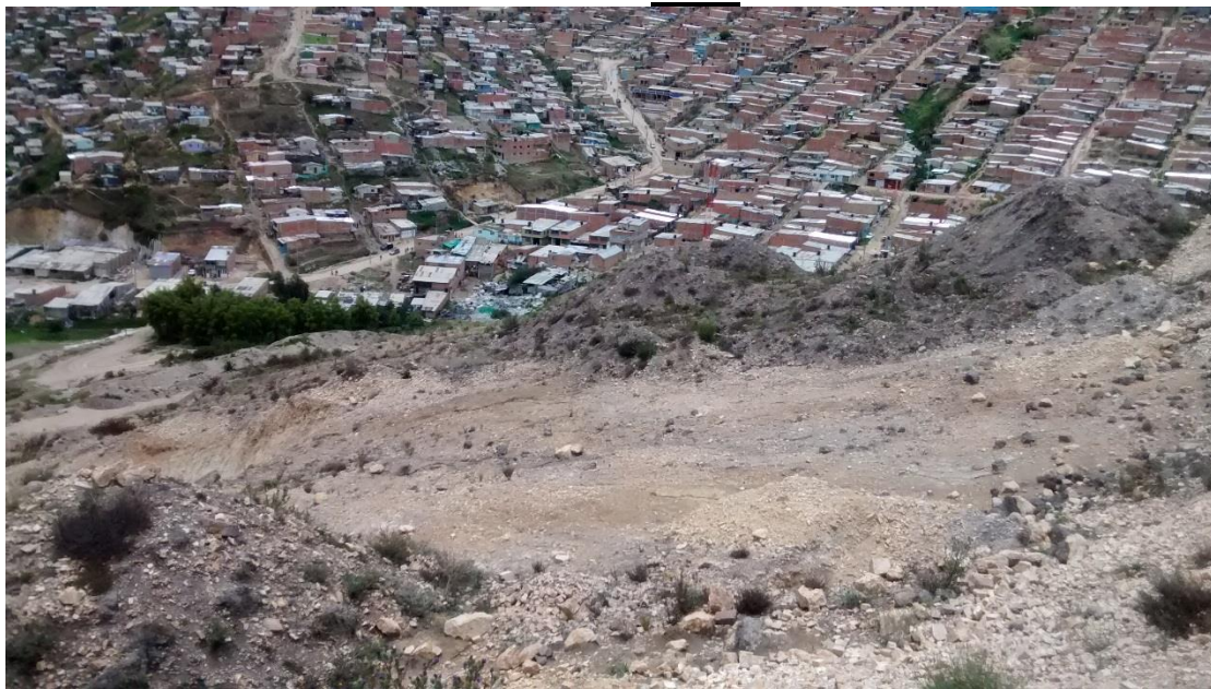
Figura 2. Área afectada por actividad extractiva de materiales de construcción del Frente NN1, por fuera del polígono Contrato de Concesión Minera No. 15558.
